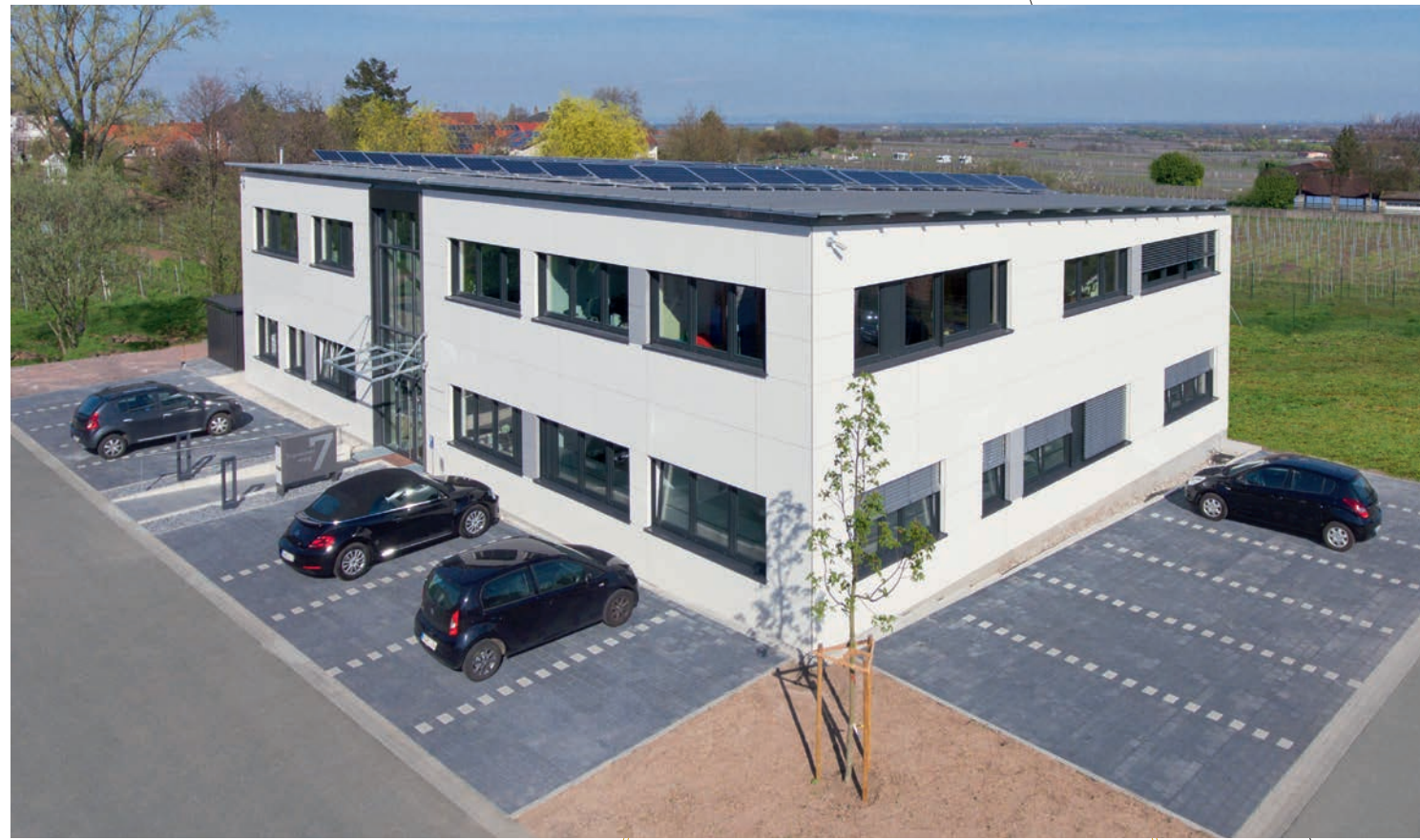
EINGEZOGEN: SEIT JANUAR 2017 BEFINDET SICH UNSER NEUES BÜRO IM TRAMINERWEG 7 IN RHODT UNTER RIETBURG
